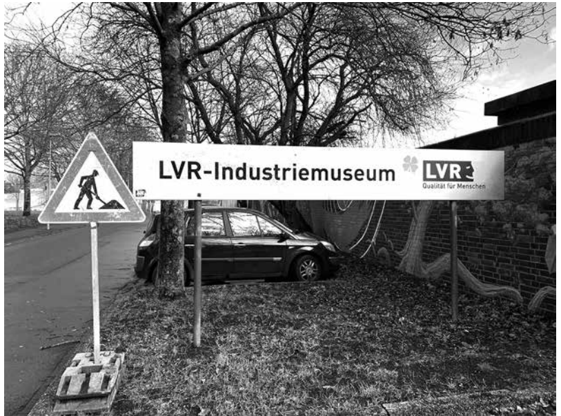
Die Baustelle am LVR-Industriemuseum Zinkfabrik Altenberg ist eingerichtet. 4.2.2020; Foto: Marcus Rischmüller/LVR.
